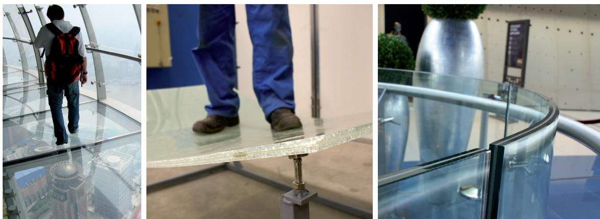
Con el fin de proteger a personas y bienes de las amenazas naturales o provocadas por el hombre, la tecnología de laminación con PVB ofrece resistencia, protección y seguridad al diseño del vidrio. El vidrio laminado con el PVB estructural proporciona además una protección continua, que ayuda a mantener la integridad de la construcción y a evitar lesiones y daños en caso de rotura del vidrio; debido, entre otras posibilidades, a desastres naturales o ataques terroristas.
