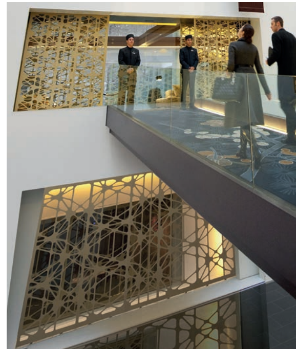
Pasarela de vidrio laminado empotrado
