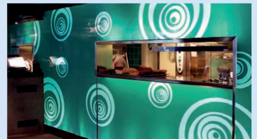
Instalación vidrio serigrafiado
