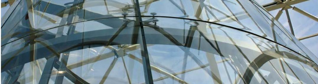
El vidrio curvado templado se obtiene mediante un calentamiento por convección, curvatura con útiles automáticos y enfriamiento rápido, por el cual se le confiere un **aumento considerable de la resistencia mecánica** y la propiedad de romper en pequeños trozos, considerándose un vidrio de seguridad.
