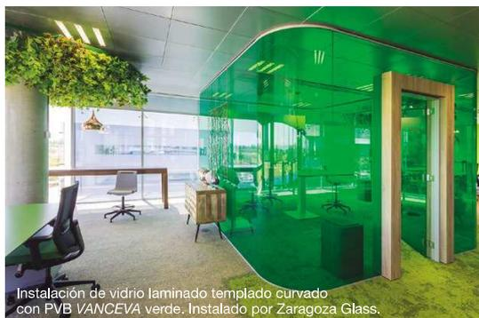
Instalación de vidrio laminado templado curvado con PVB VANCEVA verde. Instalado por Zaragoza Glass.
